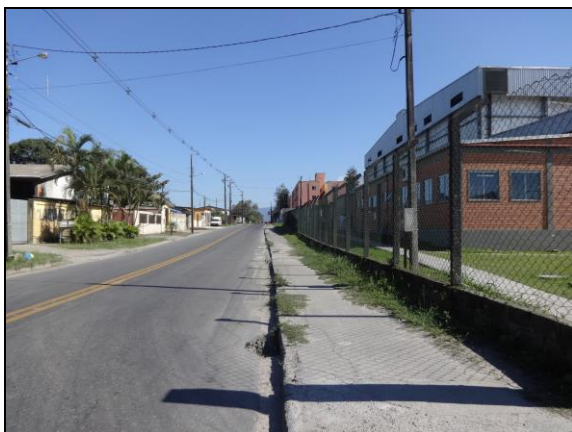
FIGURA 1 – Aspecto geral da Rua Tertuliana da Cruz dos Santos na parte frontal do imóvel. O local trata-se de área já consolidada com a vegetação já alterada.
