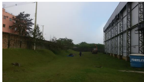
FIGURA 19 – Aspecto geral da vegetação existente da lateral direita do imóvel – Rua José Luiz Pontes.
