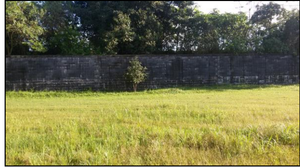
FIGURA 13 – Aspecto geral da vegetação existente na área dos fundos do empreendimento – Rua Carlos Leal Gomes.
