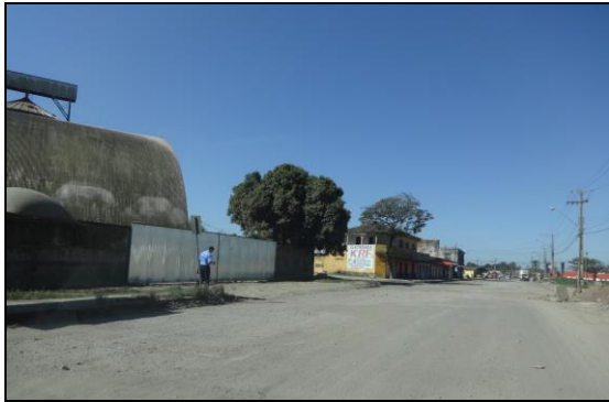
FIGURA 5 – Aspecto geral da Rua José Luiz Pontes na parte lateral do imóvel. Trata-se de área já consolidada com a vegetação já alterada.
