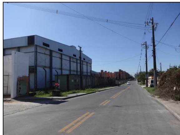
FIGURA 2 – Aspecto geral da Rua Tertuliana da Cruz dos Santos na parte frontal do imóvel. O local trata-se de área já consolidada com a vegetação já alterada.
